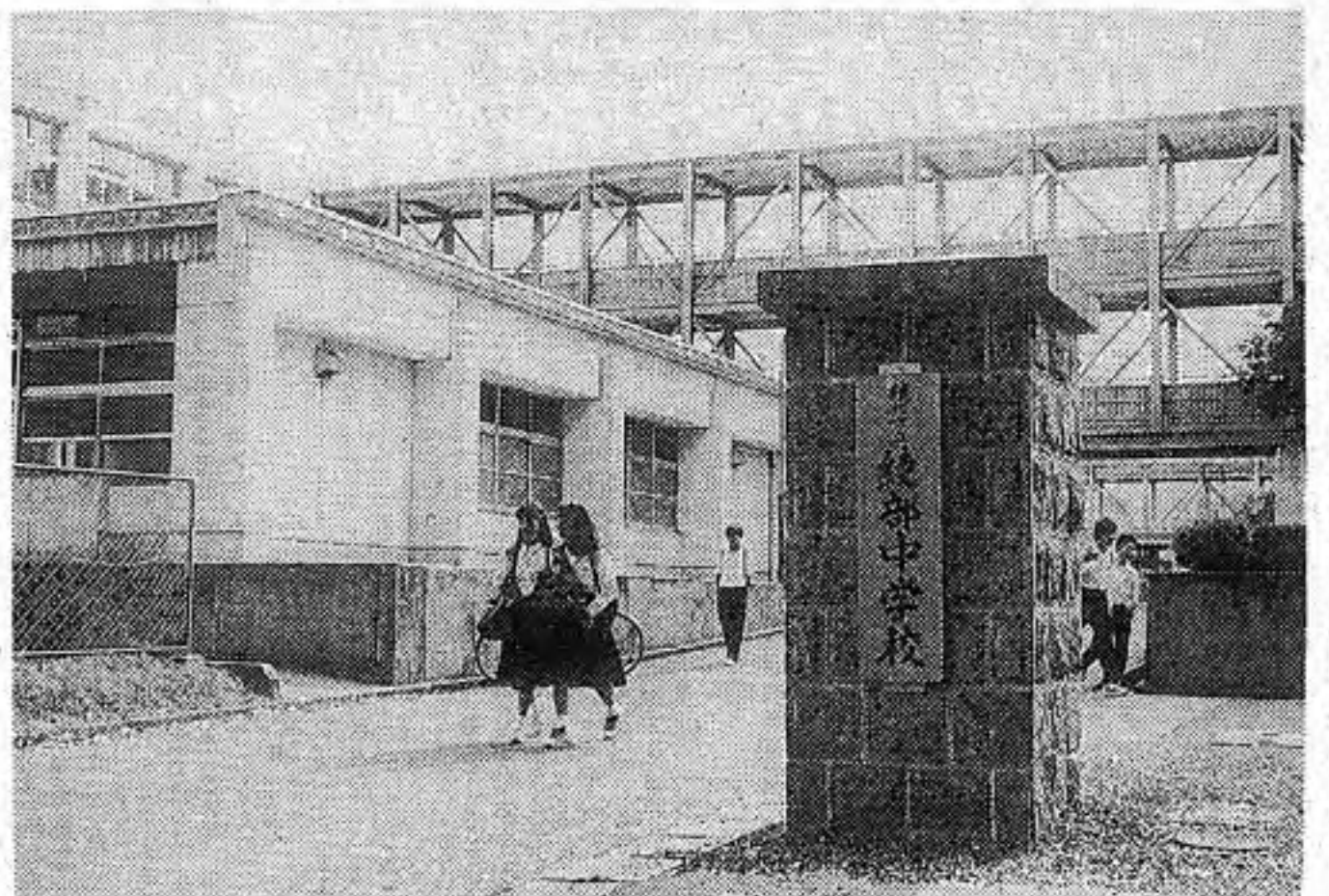
移転された現在の正門。これより奥は当然のことながら校内となる(宮代町で)
